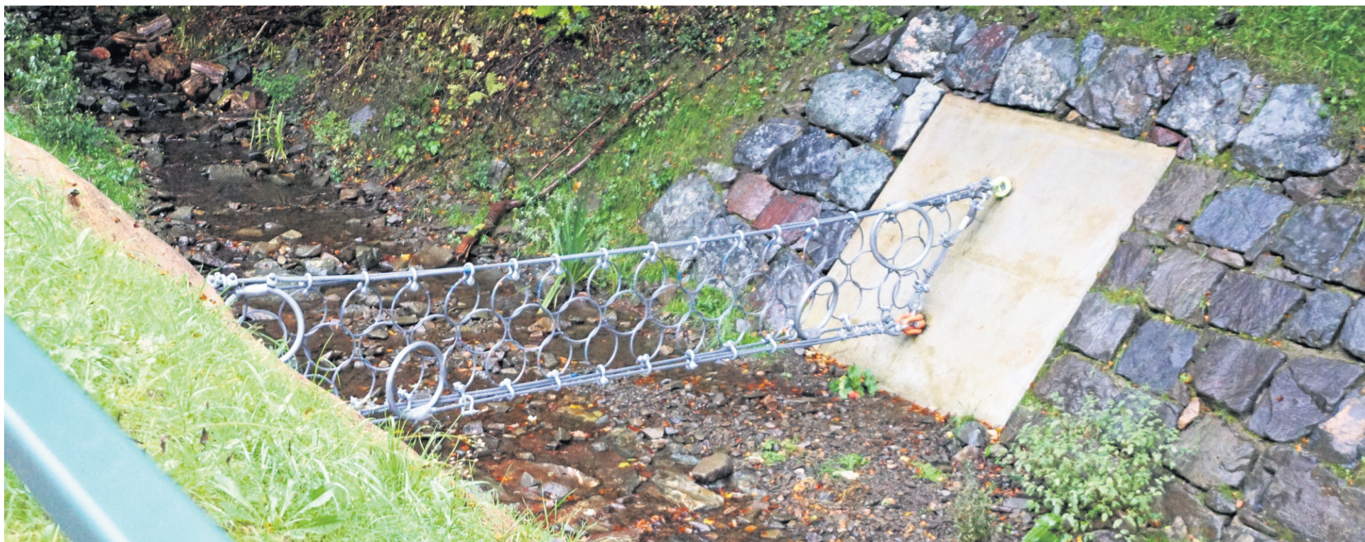
Die Wildholzsperrre soll Überschwemmungen wie im Jahr 2007 verhindern. Sie wurde im April dieses Jahres fertiggestellt.
