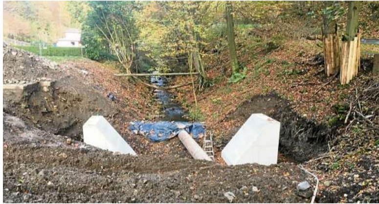
Blick auf die Erdarbeiten im Bachbett. FOTO: THOMAS BECK
