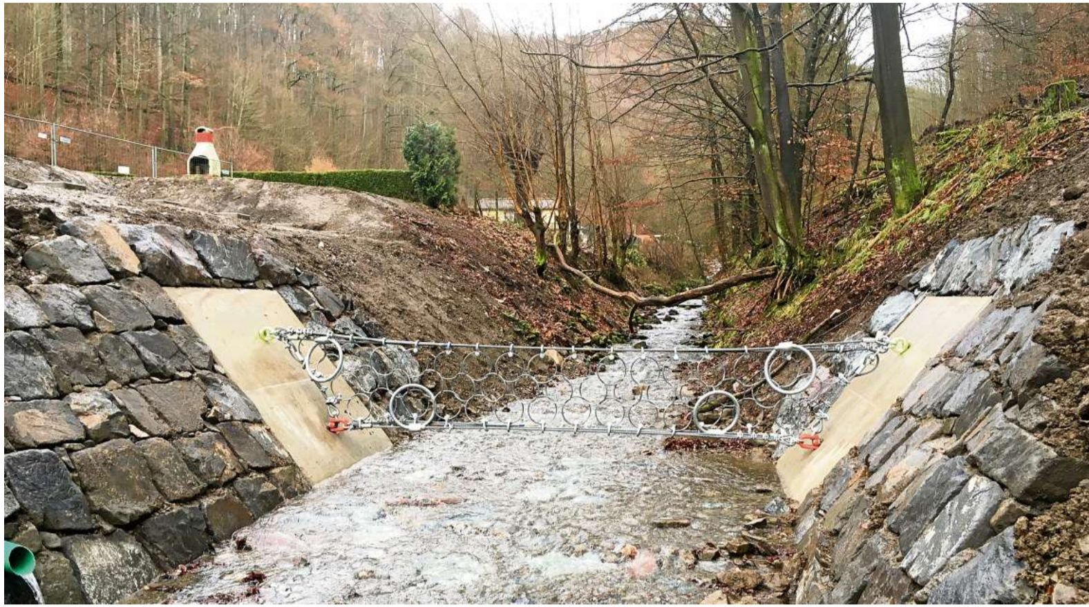
Die Arbeiten an der sogenannten „Wildholzsperrre“, laut Ortsbürgermeister Thomas Beck das erste derartige Bauwerk im Harz, sind fertig. FOTO: THOMAS BECK
