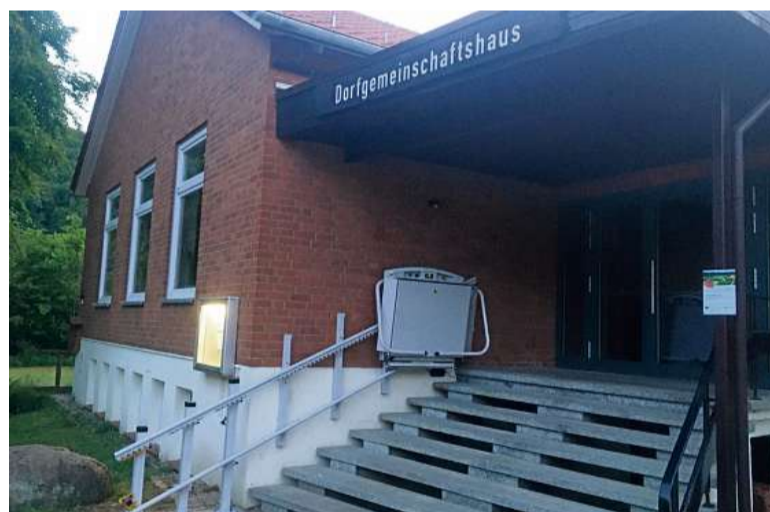
Neuer Treppenlift am DGH-Eingang.
